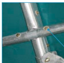
Solidité renforcée par verrouillage par vis autoforeuses
